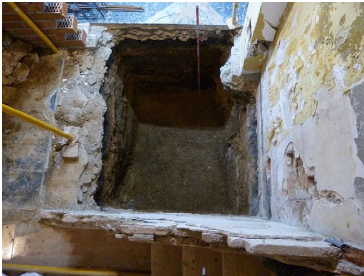
Vista del fossat de l'ascensor un cop finalitzada l'excavació
