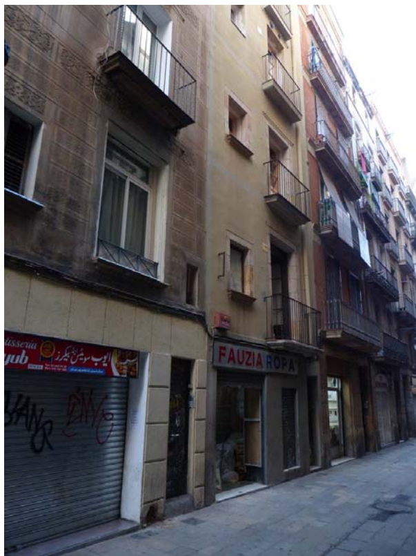
Vista de la façana de l'edifici del carrer de Sant Pau, 41
